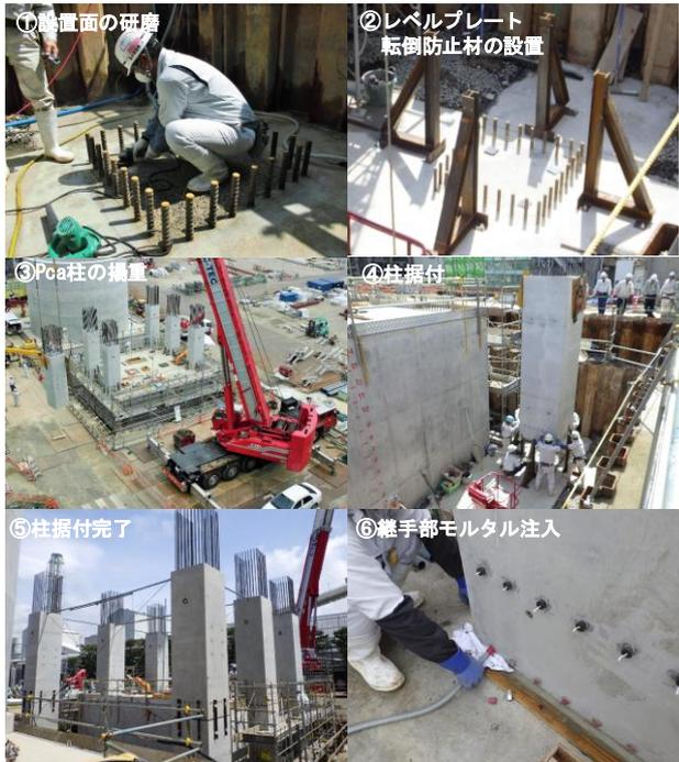
図 3 PCa 柱の施工
