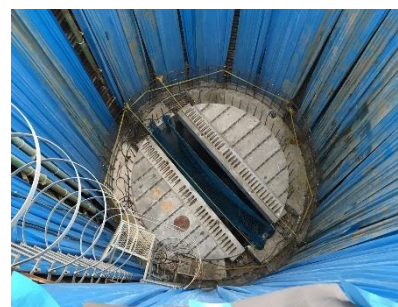
写真-2 HPCa パネル 設置状況
