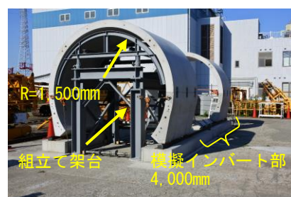
写真-1 模擬覆工全景
