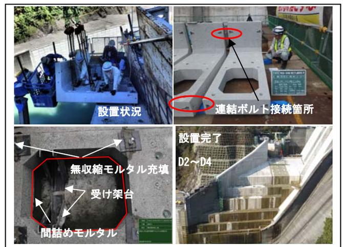
写真-1 PCa 型枠の設置状況
