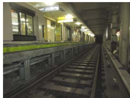
写真1 ホーム補強完成時
