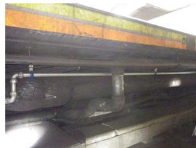
写真5 ホーム下配線、配管状況
