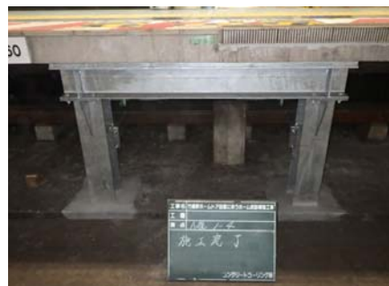
写真2 鋼材の柱による補強方法
