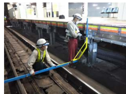
写真3 建築限界確認状況
