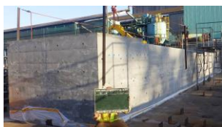
写真-2 高流動無収縮コンクリート出来形
