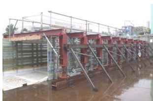
写真-1 試験施工用型枠
