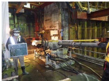
写真-1 MJS工法施工状況
