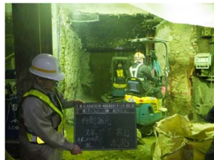
写真-2 右側掘削(1次)状況
