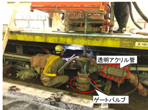
写真-1 施工状況
