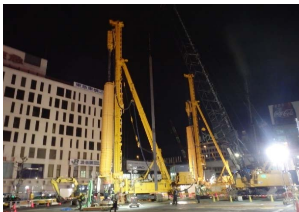
写真1 渋谷駅西口地下施設 施工状況（左：土留壁施工状況，右：地下構造物施工状況）
