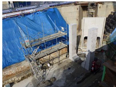
写真-3 U型水路施工状況
