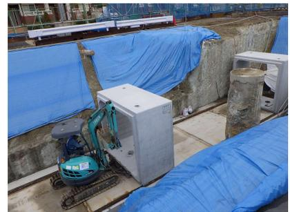
写真-4 函渠ボックス施工状況
