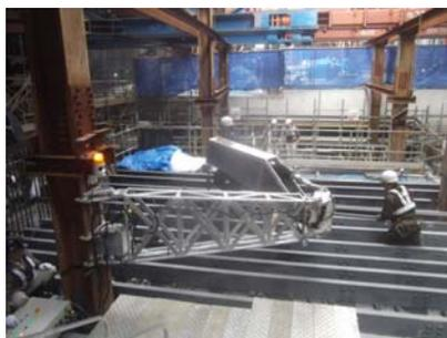
写真-5 鉄筋アシストロボット
