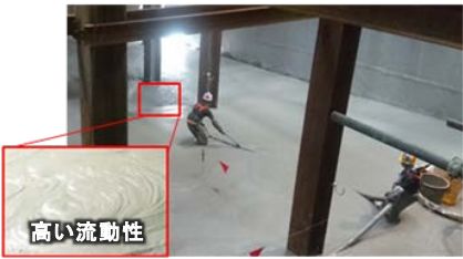
写真-1 HGS の打設状況
