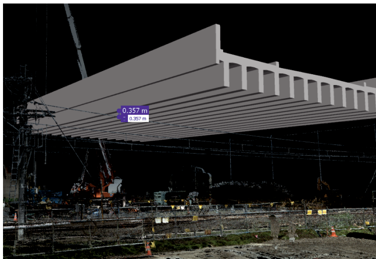
図-4 3次元空間による離隔確認状況(下り線2 鹿児島方)
