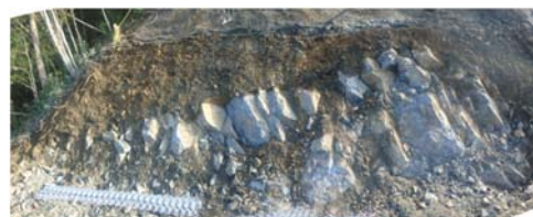
写真-4 岩盤法面仕上がり状況
