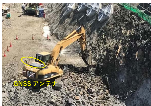
写真－2 MG 大型ブレーカによる法面整形
