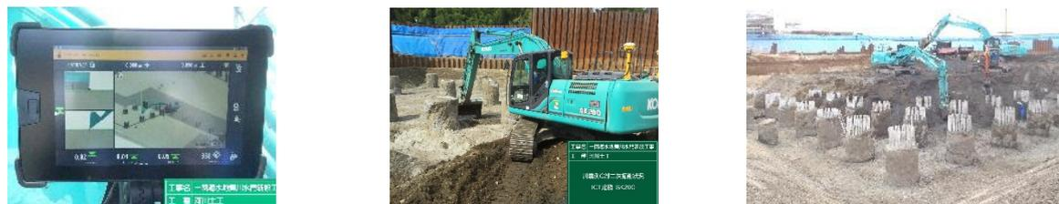
写真-1 MC バックホウによる杭頭周囲の掘削状況
