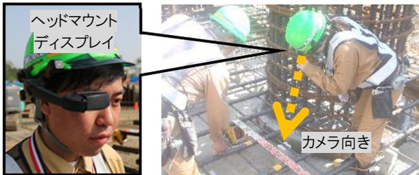
写真-2 遠隔指示による鉄筋検査の実施状況 (右：一関出張所と現場での共有画面)
