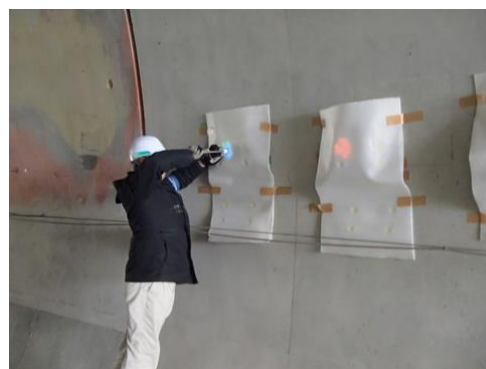
図6 パイプの差し込み作業
