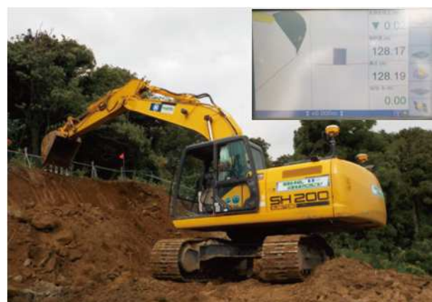
図-2 マシンガイダンスバックホウによるのり面整形
