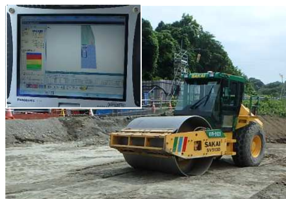
図-5 GNSS 転圧管理システムと振動ローラー
