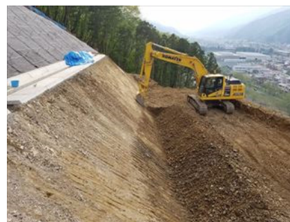
図-4 丁張レスでの法面整形状況
