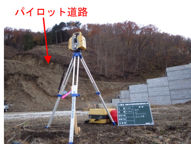
図-2 TLS 計測状況
