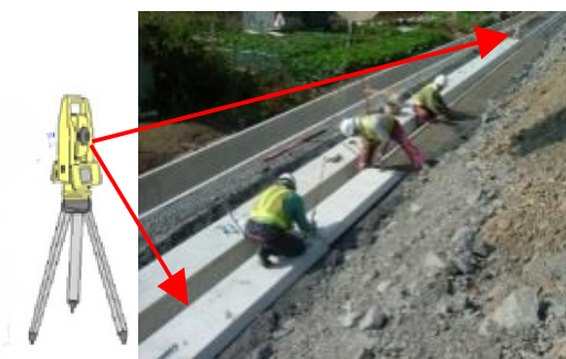
図 2 ICT 付帯構造物設置
