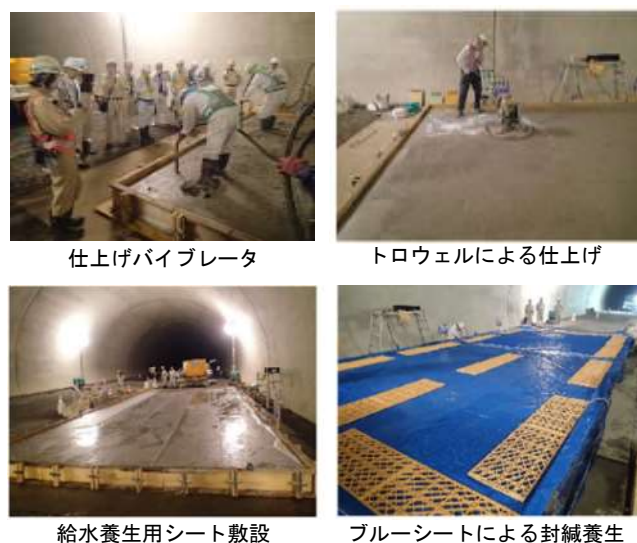
写真-1 試験施工の実施状況
