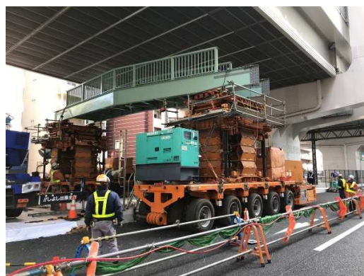
写真-1 ドーリーでの架設状況
