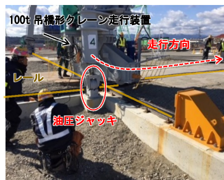
写真-3 走行装置の旋回状況
