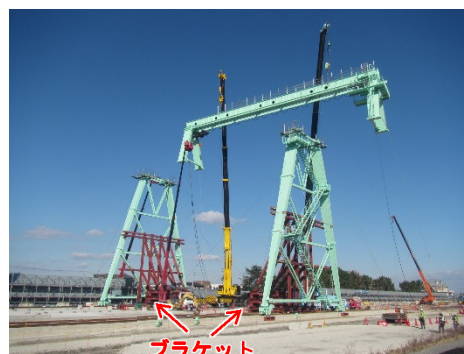
写真-1 主桁架設状況
