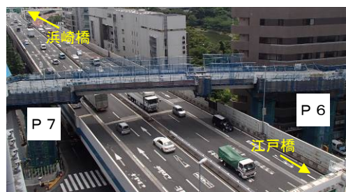
写真-3 一括架設の完了状況
