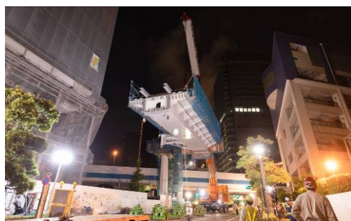
写真-2 桁の吊上げ状況（地組位置）
