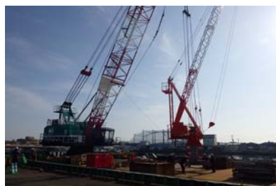
写真-3 起重機船積み
