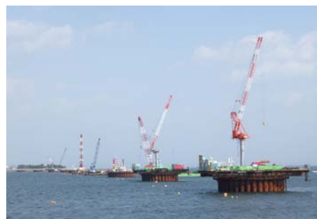
写真-1 施工状況
