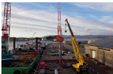
写真-2 タワークレーン地組
