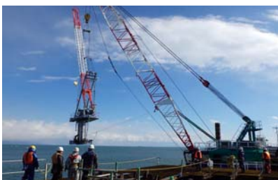
写真-4 海上運搬から設置
