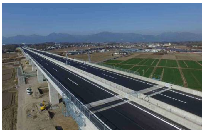
写真-2 小牧高架橋完成写真
