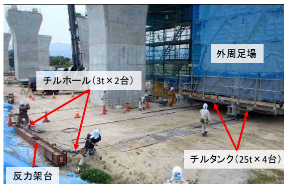
(2) 下部作業台横移動状況 写真-1 ワーゲン横移動写真
