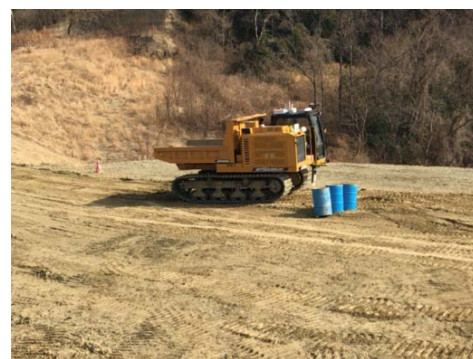
図-6 障害物回避状況
