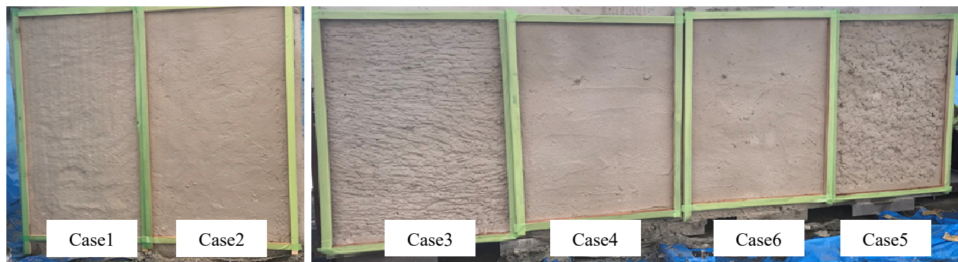
写真-2 下地処理方法による塗膜防水材吹付け面の違い
