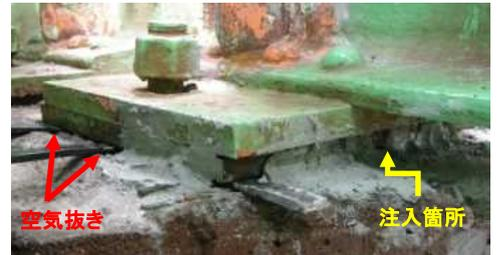
図5 止水モルタル施工
