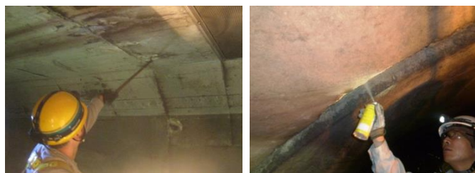
写真 1 打音検査状況
