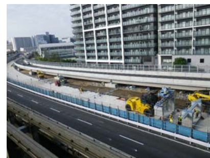
図-4 セグメント架設全景
