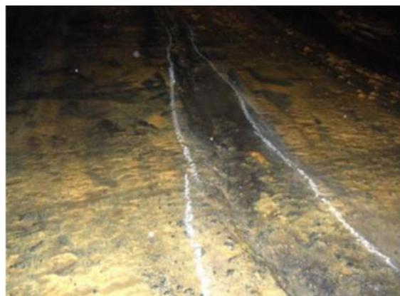
図-2 3期水路トンネル継目部の洗掘
