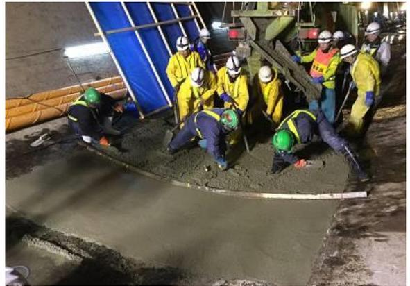
図-4 コンクリート打設状況(従来工法)
