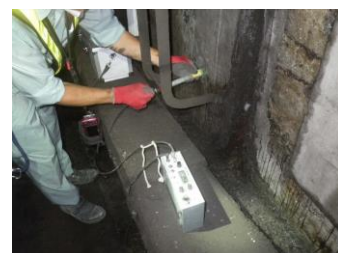
図-9 自然電位測定状況
