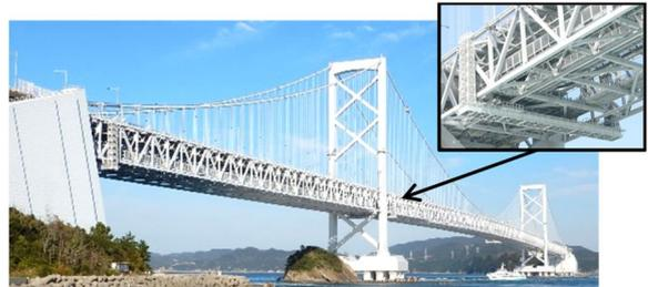
写真-1 大鳴門橋と桁外面作業車
