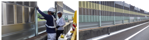
写真-2 反射型エバードライ設置状況
