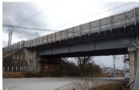
写真-1 試験施工橋りょう
