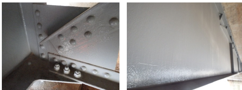
写真-4 外観調査 (左：対傾構 右：腹板)
