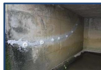
(図-2) 橋梁修繕・ひび割れ注入
