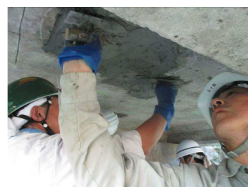
写真-6 床版下面補修状況
