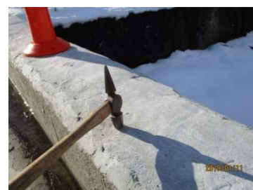
写真-7 主桁(下流)モニタリング
