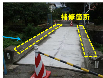
写真-1 補修実証橋梁
