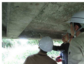
写真-2 床板下面状況
