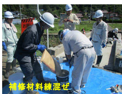
写真-5 主桁（下流）補修状況
