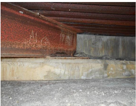
写真-2 桁端部(横桁無し)
