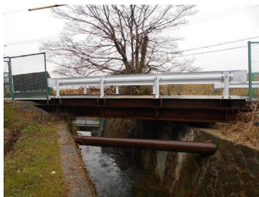
写真-6 復旧のために架設した応急橋
