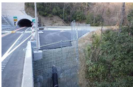
写真-5 立入防止柵施工状況
