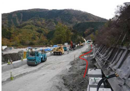
写真-7 管路(赤線)の切り回し例
