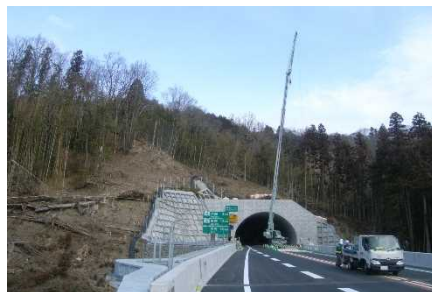
写真-3 TN坑口での伐採状況
