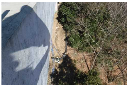
写真-2 斜面での排水施工状況
