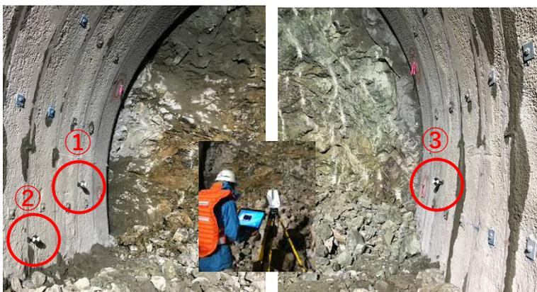
図-2 点群点ターゲット 3 点配置状況
