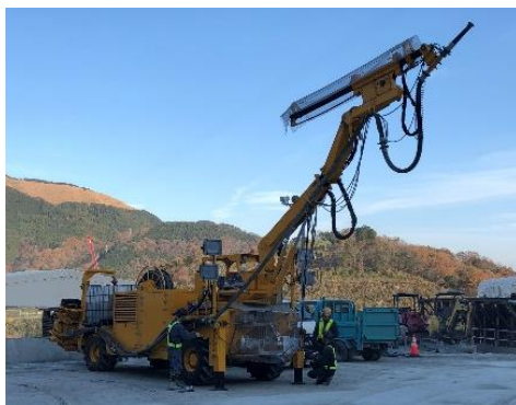
写真-1：一体型吹付機
