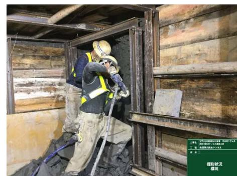
写真 - 3 導水迂回坑掘削状況
