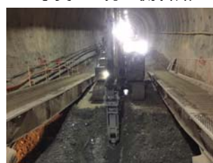
写真4 中央排水工施工状況
