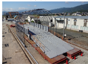
写真2 坑口側斜路
