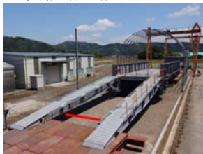
写真3 切羽側斜路の分割
