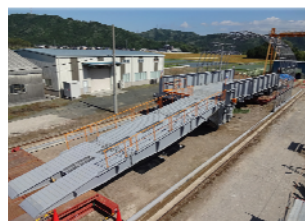
写真1 切羽側斜路（横移動可能）
