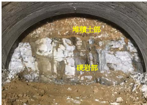
写真-2 当該区間（0～80m）における切羽状況
