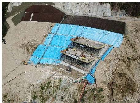
写真-1 坑口部遠景と注入実施状況
