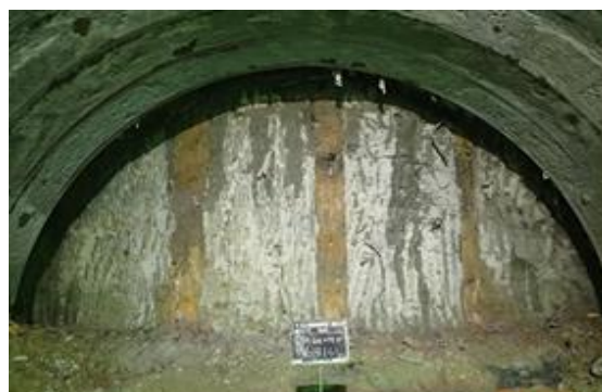
写真-1 CSM工法地盤改良区間の切羽
