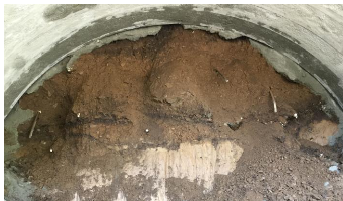
写真-1 岩屑流堆積物が出現した坑口部
