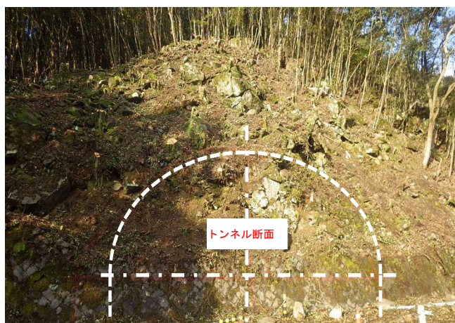
写真-1 伐採後の坑口部状況
