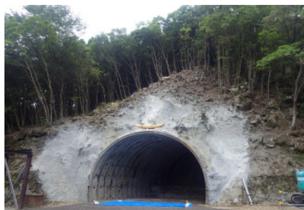
写真－3 坑口付け完了
