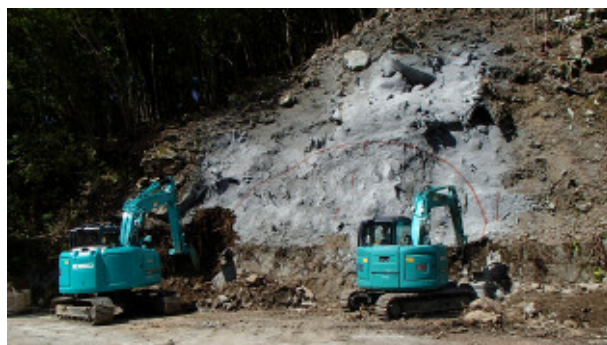
写真－2 転石、浮石除去、法面吹付け完了
