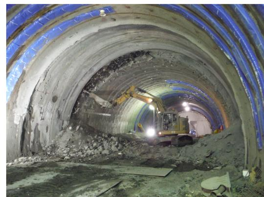
写真-4 縫返し掘削状況
