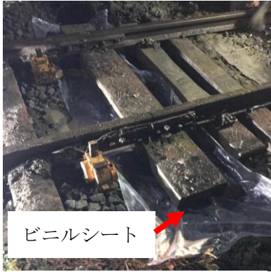
写真 1. 施工の状況①
