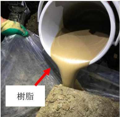
写真 2. 施工の状況②
