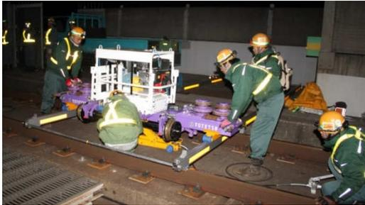
写真-2 器材横取り装置：ワタレール
